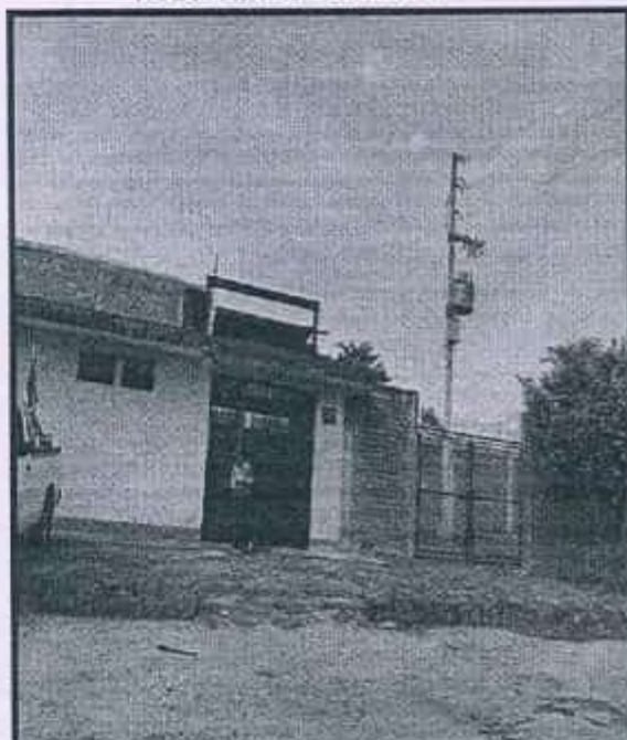
Pozo Villa El Salvador
