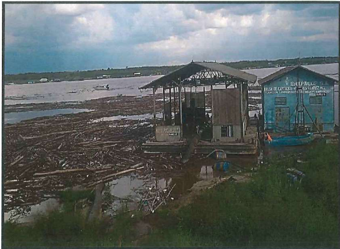
Ilustración 4 Palizada acumulada cercana a las Balsa de Captación durante los meses de Diciembre
