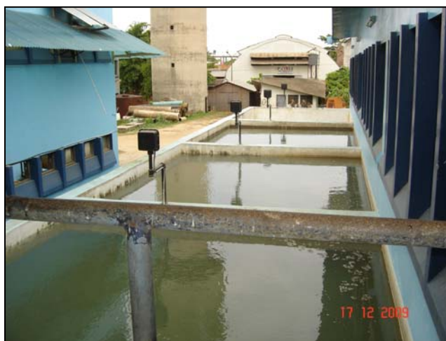
Foto N°7: Batería de Filtros
