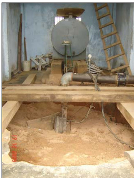
Foto N°4: Pozo Colapsado - Yarinacocha
