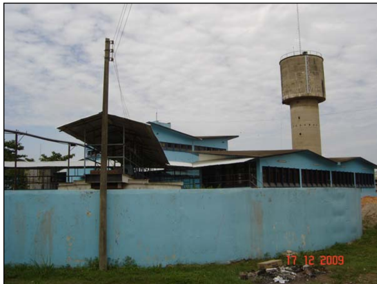
Foto N°6: Planta de Tratamiento de Agua – Sede EMAPACOP S.A.
