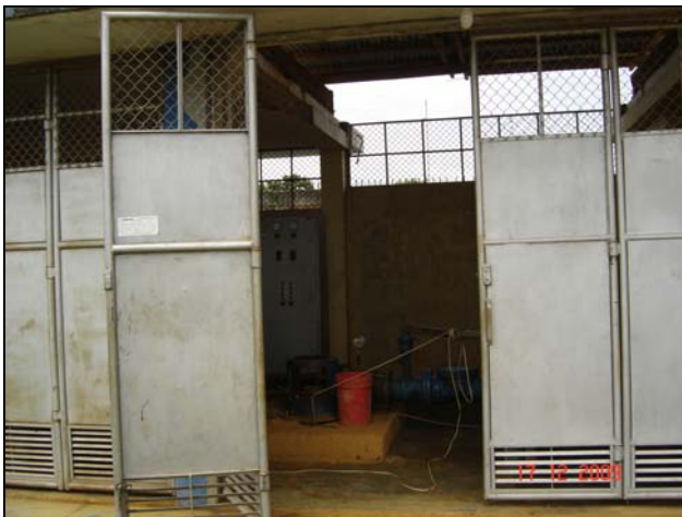
Foto N°2: Caseta de Pozo
