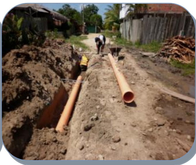
Ampliación de red secundaria para agua potable
