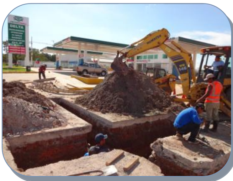
Instalación de Hidrante, esquina Centenario con Túpac Amaru
