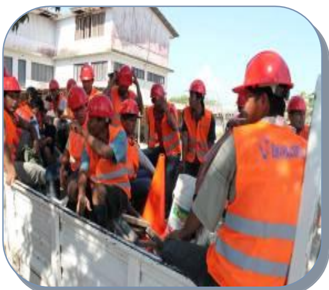
Equipo de trabajadores del Programa limpieza de redes.
