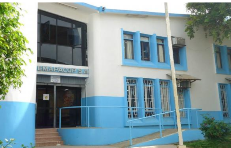
Empresa Municipal de Agua Potable y Alcantarillado de Coronel Portillo S.A.
