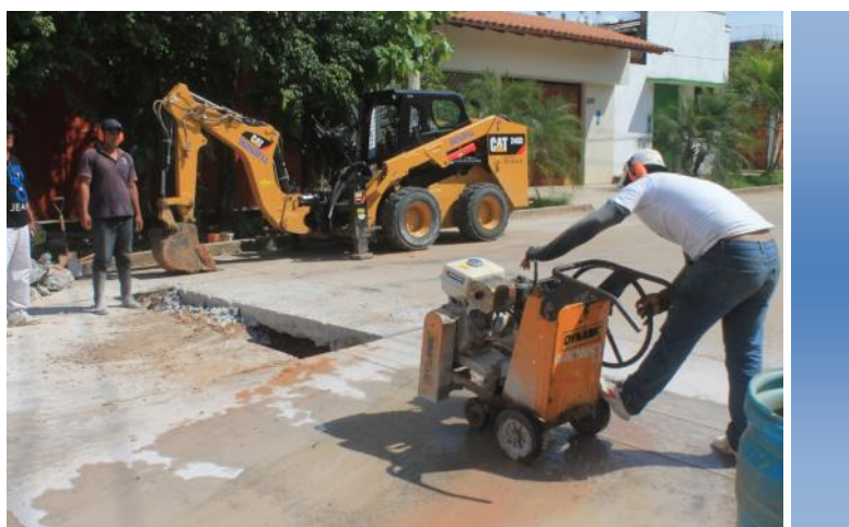
Trabajos de arreglo de ruptura de conexión de agua en zona céntrica de la ciudad
