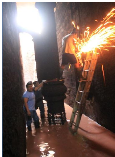
Mantenimiento de contrapuerta del tanque reservorio
