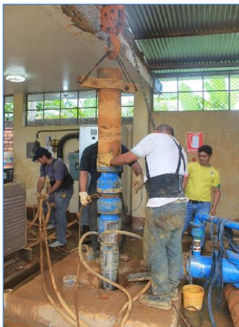
Trabajos de cambio de Electro bomba
