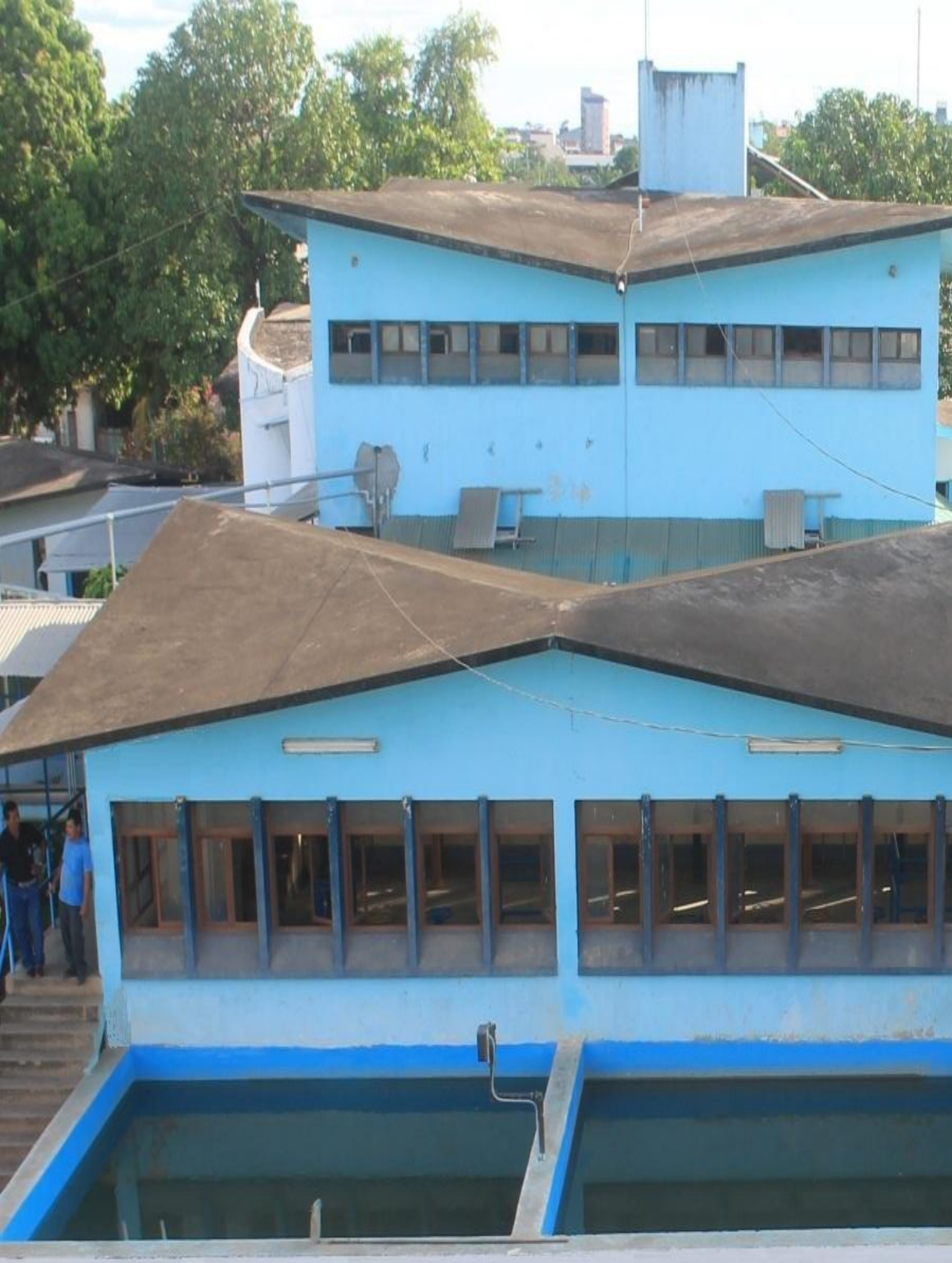
BATERÍA DE FILTROS REHABILITADA – PLANTA DE TRATAMIENTO
