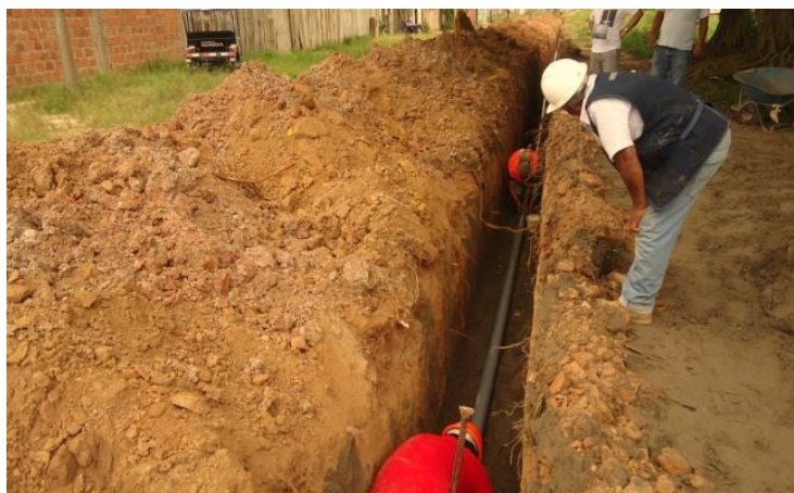
Foto N° 01: se observa la instalación del tubo de 110 mm clase 7.5 en la zanja para su debido empalme con la respectiva supervisión del maestro de obra
