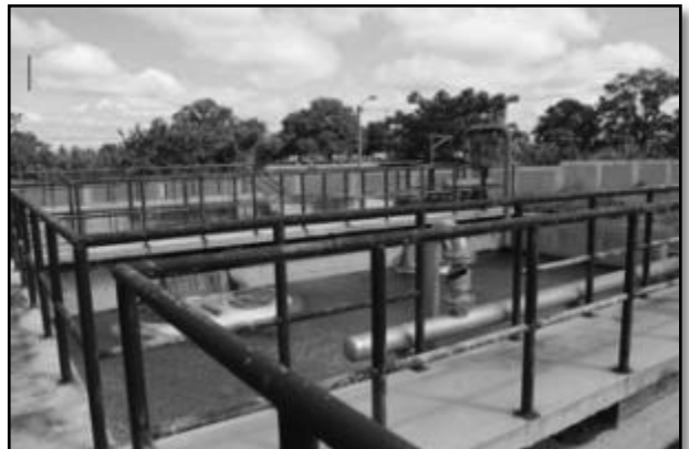
Imagen N° 51: PTAR N° 03 Lodos Activados
