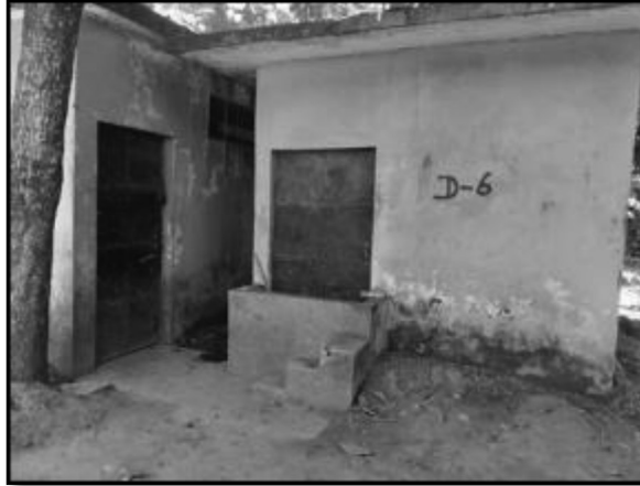
Imagen N° 37: Cámara de Bombeo de Desagüe D-6
