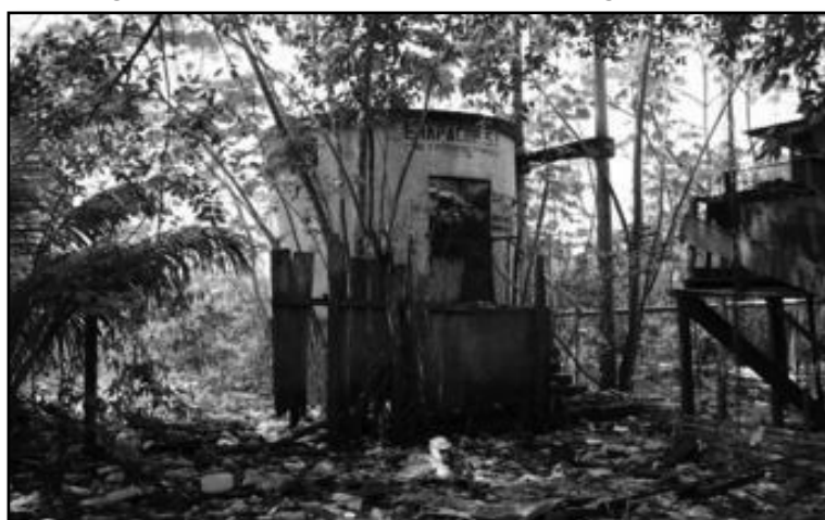
Imagen N° 30: Cámara de Bombeo de Desagüe D-12
