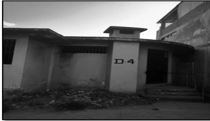
Imagen N° 35: Cámara de Bombeo de Desagüe D-4
