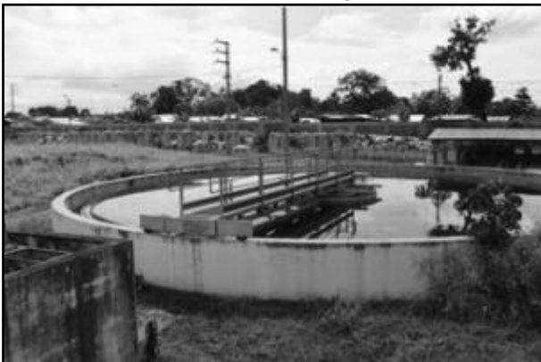
Imagen N° 51: PTAR N° 03 Lodos Activados
