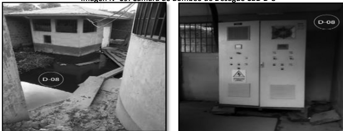
Imagen N° 39: Cámara de Bombeo de Desagüe CBD D-8
