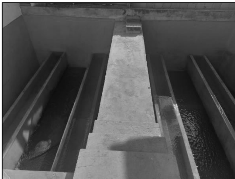
Imagen N° 24: Batería de Filtros
