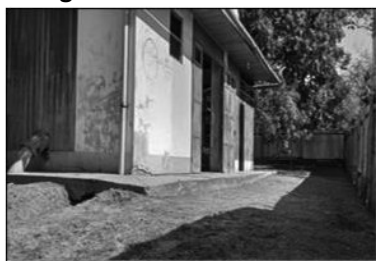
Imagen N° 11: Pozo Palmeras II
