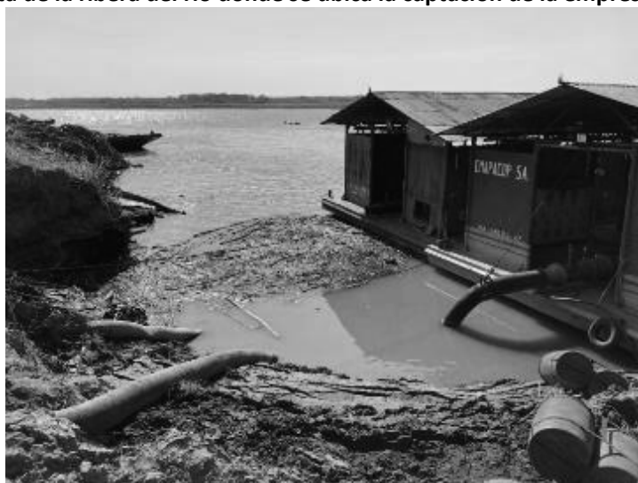
Imagen N° 56: Vista de la ribera del río donde se ubica la captación de la empresa prestadora
