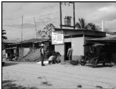
Imagen N° 36: Cámara de Bombeo de Desagüe D-14
